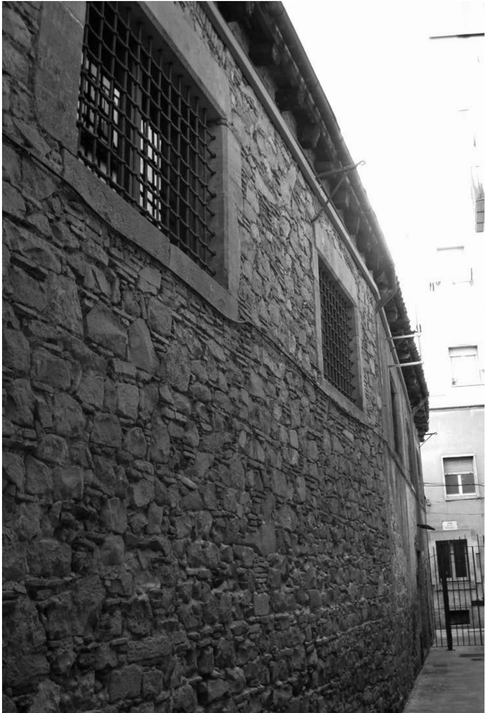
Façana de la Seca que tocava al carrer de la Seca. Fotografia Toni Ripoll.
