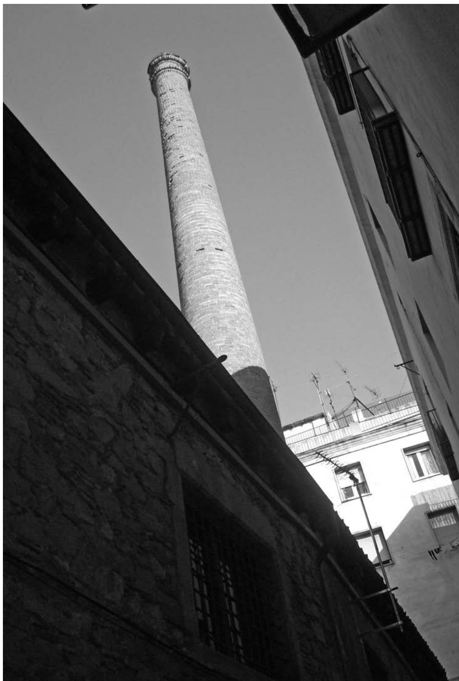
Façana i xemeneia de la Seca. Carrer de la Seca. Fotografia Toni Ripoll.
